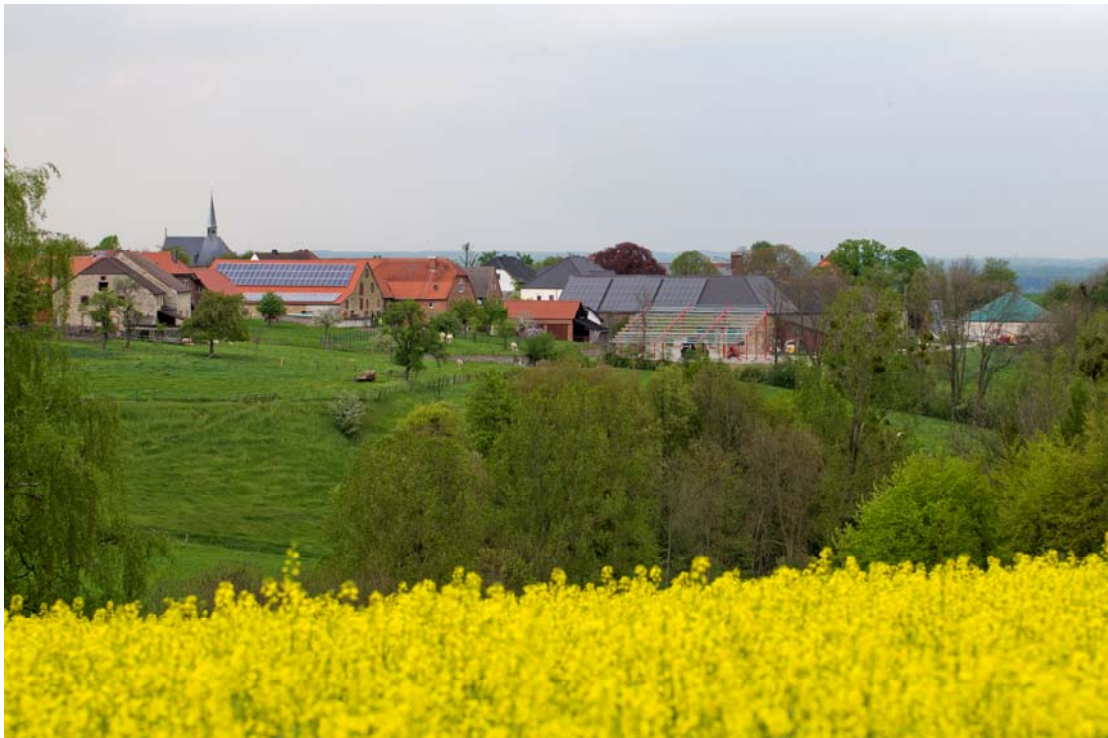
Robringhausen in der Landschaft. Rechts der Fermenter der Biogasanlage
