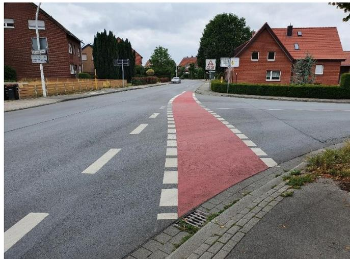
Abbildung 3: Beispielhafte Einfädelungshilfe
