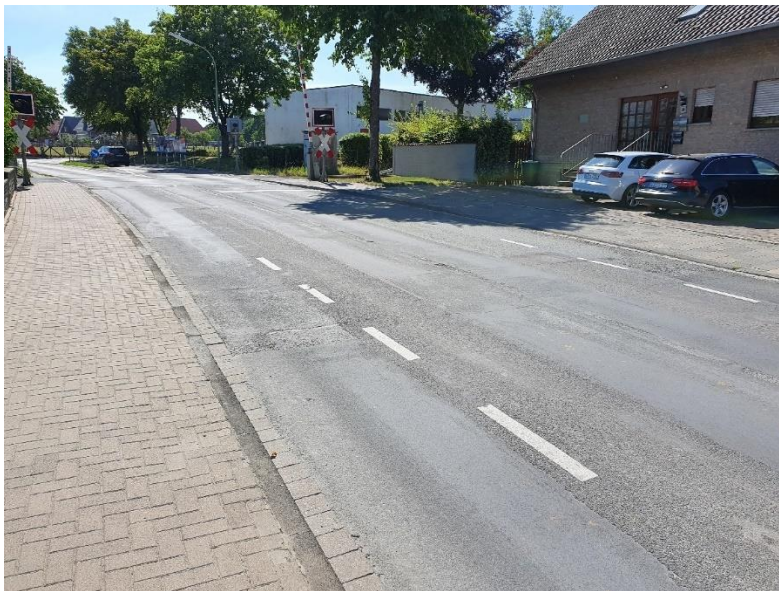
Abbildung 28: Ende des Schutzstreifens an der Kliever Straße [eigene Aufnahme]
