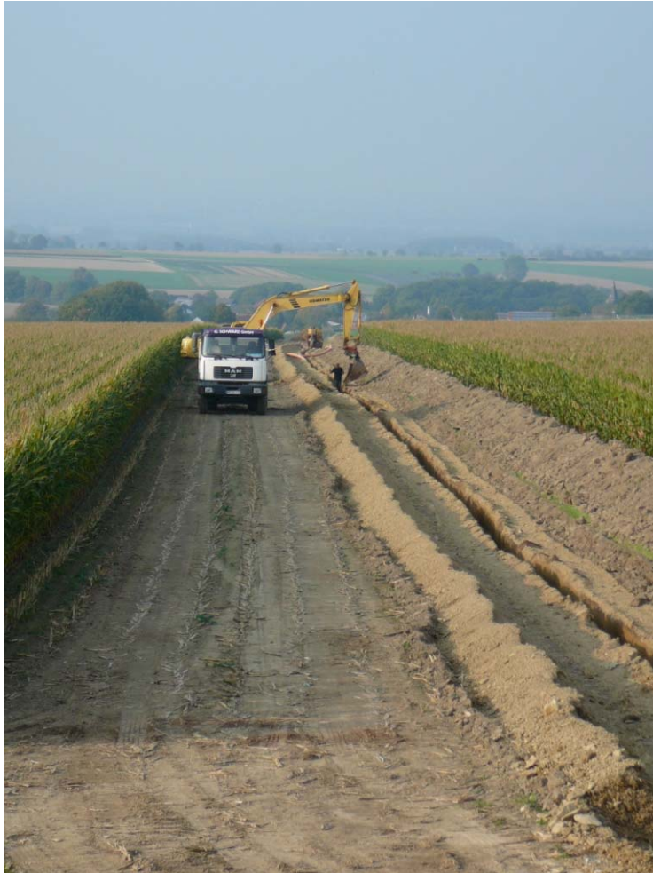
Bau der Gasleitung Quelle: Georg Dicke, Altenmellrich 2011
