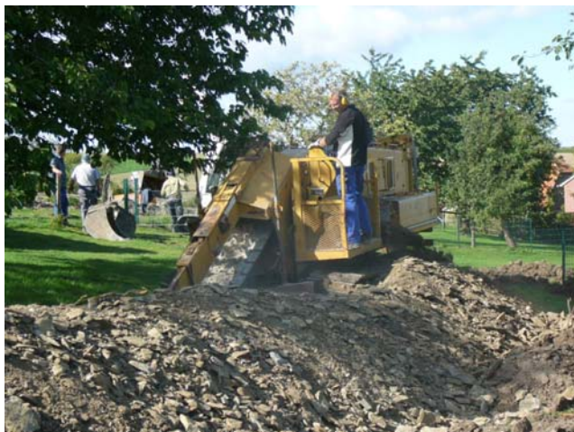
Bau des privaten Nahwärmenetzes Quelle: Rudi Sommer, Robringhausen 2008
